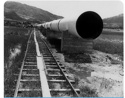
接收深圳水庫供水的大型水管，直徑約48吋。
